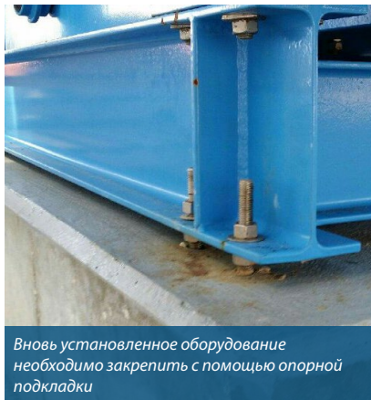
Для фиксации использован монтажный компаунд Belzona со 100%-ным содержанием твердого вещества
