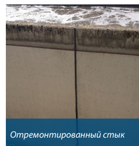
Компенсационный шов герметизирован с помощью Belzona
