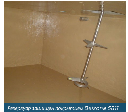
Резервуар защищен покрытием Belzona 5811
