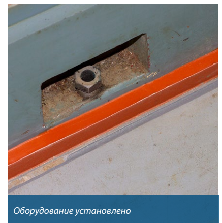
Для фиксации использован монтажный компаунд Belzona со 100%-ным содержанием твердого вещества
