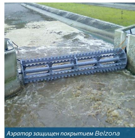
Стенки восстановлены и защищены от износа
