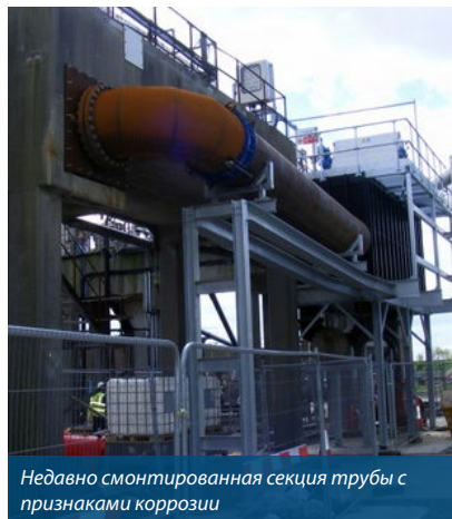
Нанесено химически стойкое покрытие
