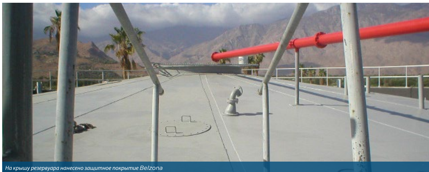
Резервуар отремонтирован методом холодного склеивания
