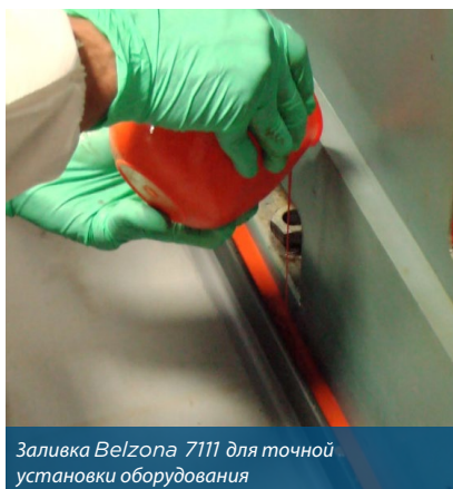
Вновь установленное оборудование необходимо закрепить с помощью опорной подкладки
