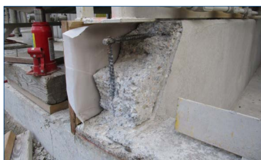
Полное удаление разрушенного бетона
