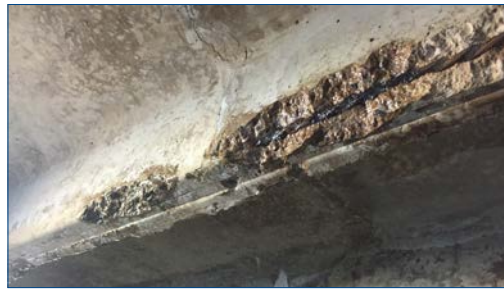
Разрушенное бетонное перекрытие на автостоянке
