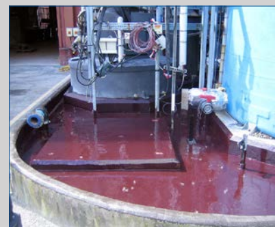
Ограждающая стена в зоне обвалования восстановлена и защищена покрытием Belzona 4111
