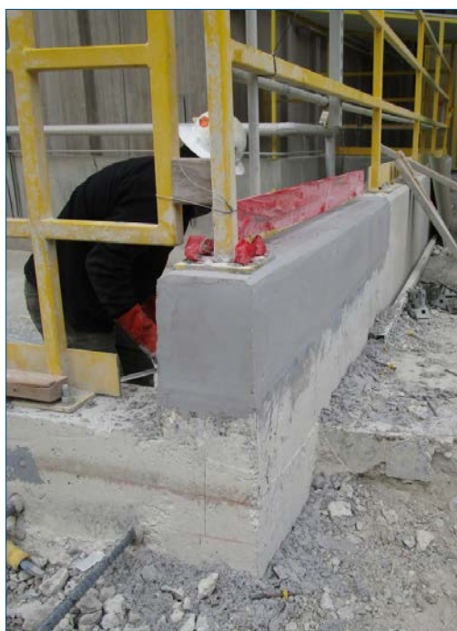
Ограждающая стена в зоне обвалования восстановлена и защищена покрытием Belzona 4111
