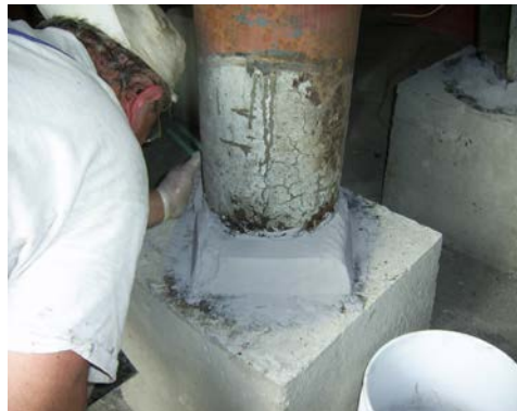
Процесс нанесения материала Belzona
