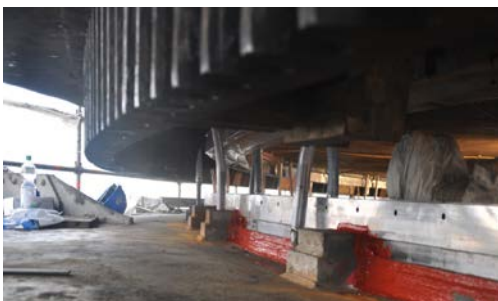
Закрепленная опора поворотного круга
