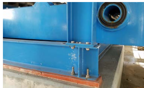
Формирование подливки: после ремонта
