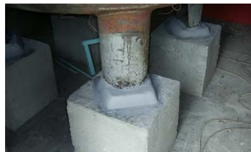
Создание компенсационной прокладки: после ремонта
