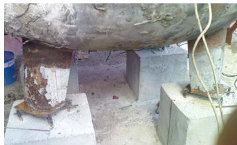
Создание компенсационной прокладки: до ремонта
