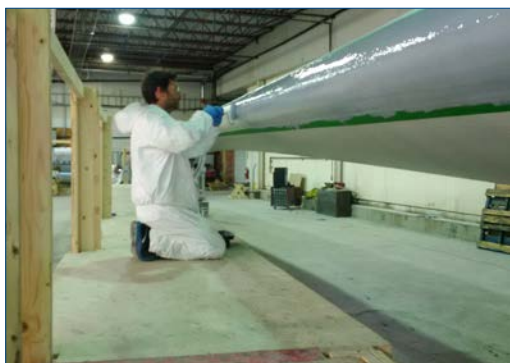
Нанесение покрытия Belzona валиком на переднюю кромку лопасти
