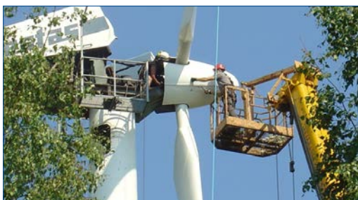
Ремонтные работы в гондоле с применением Belzona 1131 (Bearing Metal) TOM XXXII, № 48
