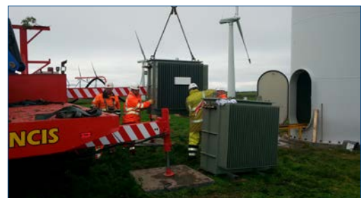
Ремонт трансформатора с помощью Belzona 1212 TOM XXXII, № 18
