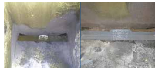
Ремонт сквозных повреждений травильного чана, заполняемого 36%-ной соляной кислотой
