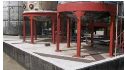
Восстановление бетонной подложки
