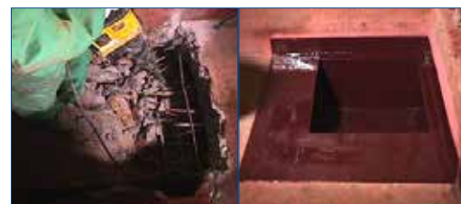
Сильно поврежденный сборник для кислоты после ремонта
