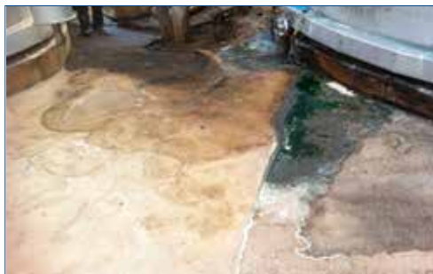
Результат воздействия кислоты при 49 °C
