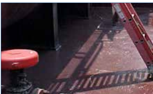
Поверхность с нанесенным покрытием после восьми лет эксплуатации
