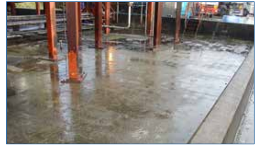
Зона обвалования до ремонта
