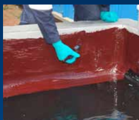
Гибкие сегменты в полимерной цепи Belzona 4361 придают покрытию гибкость
